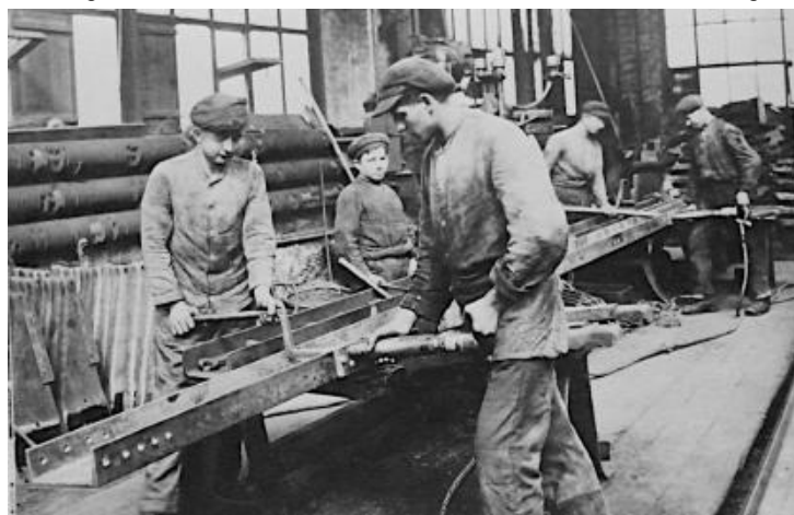
Nietarbeiten in einer Fabrik um 1920.
