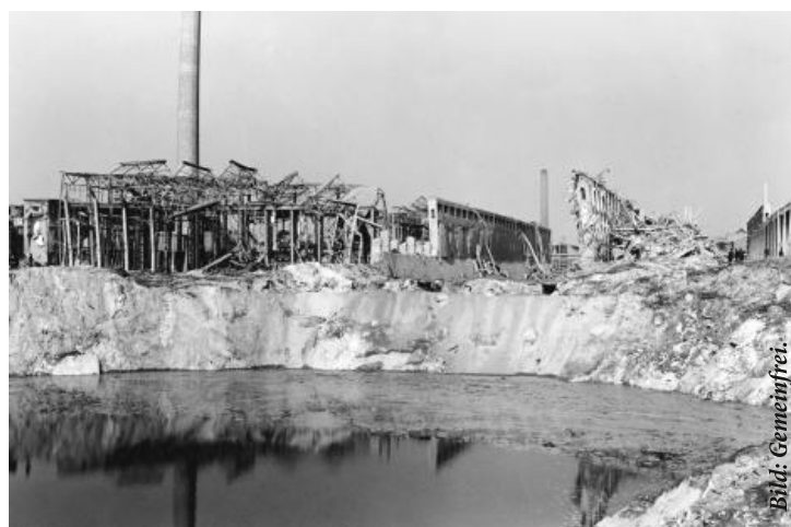
Zerstörungen im Oppauer BASF-Werk nach dem 21. September 1921.
